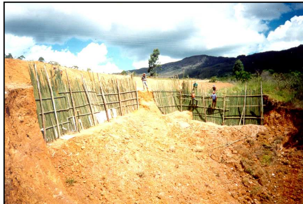
Fig. 5.9. Paliçada na parede da voçoroca.
